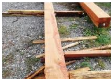
DÉBIT POUTRE MÉLÈZE
